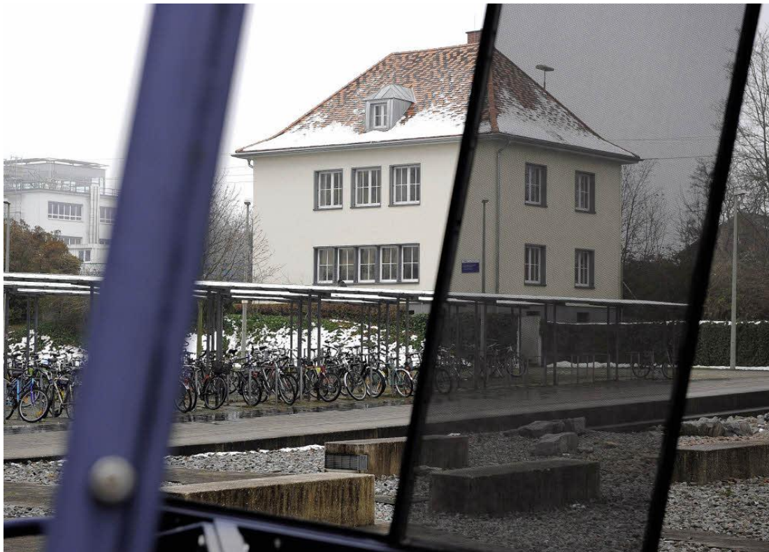
Das Passivhaus der Albert-Ludwigs-Universität auf dem Campus der Technischen Fakultät FOTO: INGO SCHNEIDER
